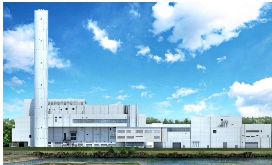
高浜クリーンセンター新設工事
