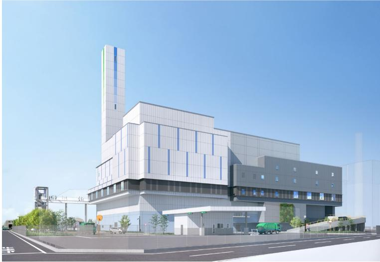
既存工場を解体し、新清掃工場を新築するプロジェクトです。省エネ設計と自然エネルギーの活用で、清掃工場では先進的なZEB Readyの認証を目指します。また、隣地には稼働中の工場があるため、運営に影響が生じない仮設・動線計画といたします。さらに一部の既存躯体の利活用により産業廃棄物を削減でき、環境に配慮した計画としています。
