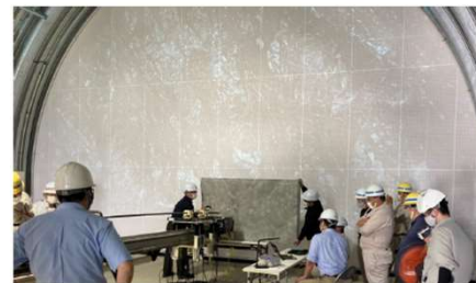
写真3 ICI総合センター模擬トンネル内 実証試験状況
