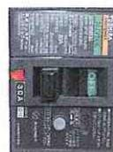
(3)設備側及び車両側の「主電源漏電遮断器」を「ON」にし電源表示灯が点灯するのを確認後漏電遮断器の「テストスイッチ」を押し正常に作動するのを確認して下さい。
