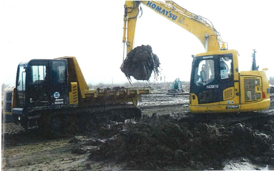
長沼地区内の水田で土砂を撤去するICT油圧ショベル
