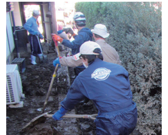
被災家屋 泥だし
