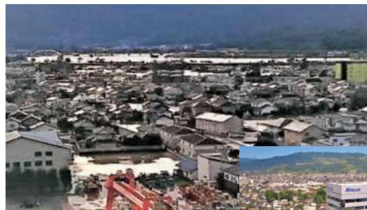
本社ビル周辺 浸水状況
