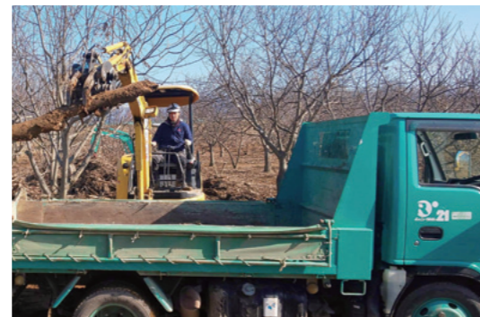
レンタル ミニショベルとダンプカー
