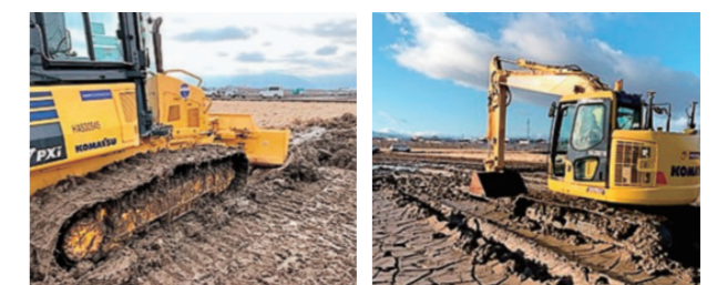
ICT建機導入の水田復旧工事
