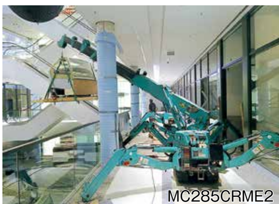
MC285CRME2 (ショッピングモール内の設備据付)
